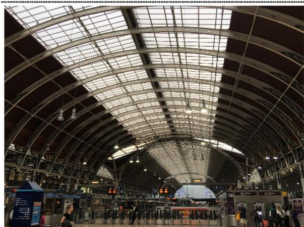
圖 2：倫敦帕丁頓站的拱形玻璃屋頂，由三個熟鐵製成的拱所支撐。
